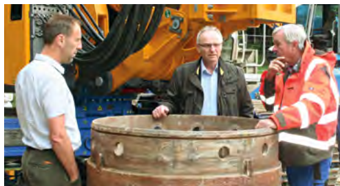
Ein Blick in die Tiefe.
