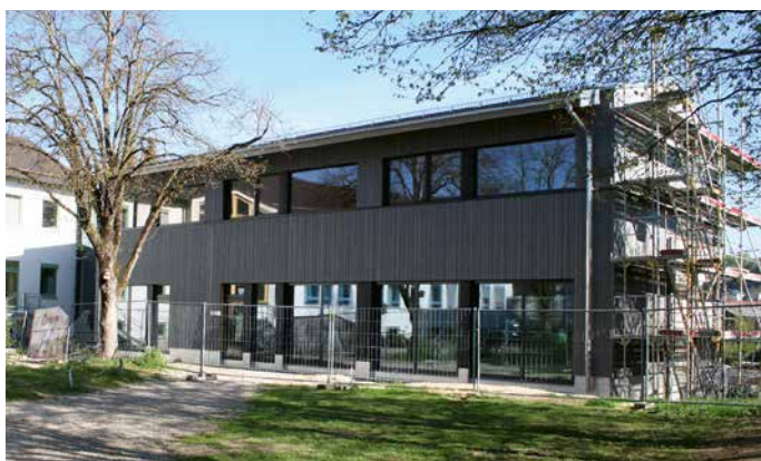
Die neue Mittagsbetreuung bietet einen direkten Zugang zur Grund- und Mittelschule und ist dank Aufzug barrierefrei | Fotos: Lezius-Pratsch/VG
